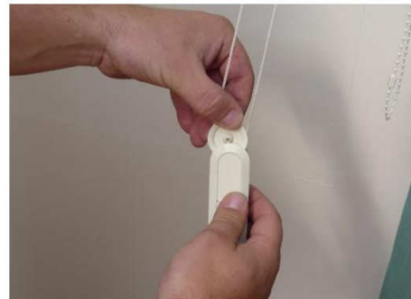
12. Na spodní část ovládacího provázku připevníme ovládací závaží.
